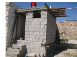
Construction de la superstructure - Juin 2010
