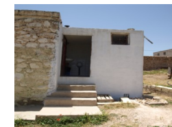
Construction de la superstructure - Juin 2010
