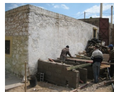
Construction des chambres et coffrage - Juin 2010
