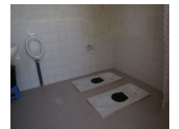
État final de la construction - juin 2010
