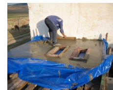
Coulage de la dalle intermédiaire - Juin 2010
