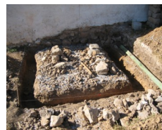
Travaux d'excavation - Juin 2010
